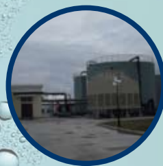
厦门东部固废处置场 处理规模800m 3 /d
