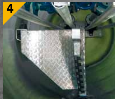
4 内置维修平台，可根据客户需要进行设计和布局。
