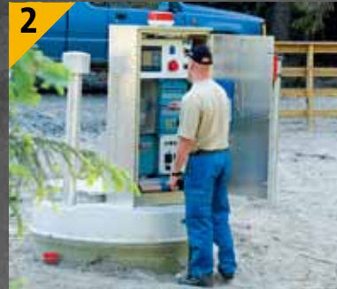
2 控制面板安装在控制柜内，控制柜可以安装在泵站顶盖上，或单独安装在地面，也可放在维修间内。
